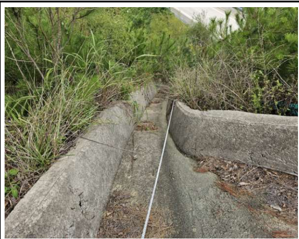
위 치 산마루측구 현 황 전경
