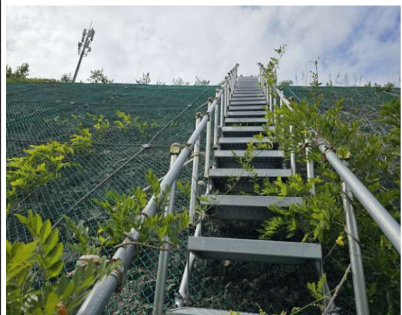
위 치 점검사다리 현 황 전경
